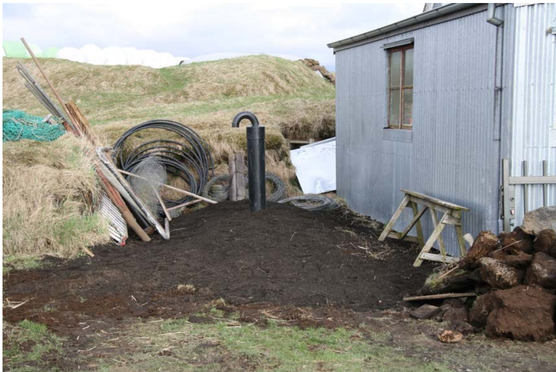
Mynd 11. Er rotþrónni hafði verið komið fyrir í gryfjunni var fyllt upp í kring um hana með sandi . (GÓL2007-7-78).
